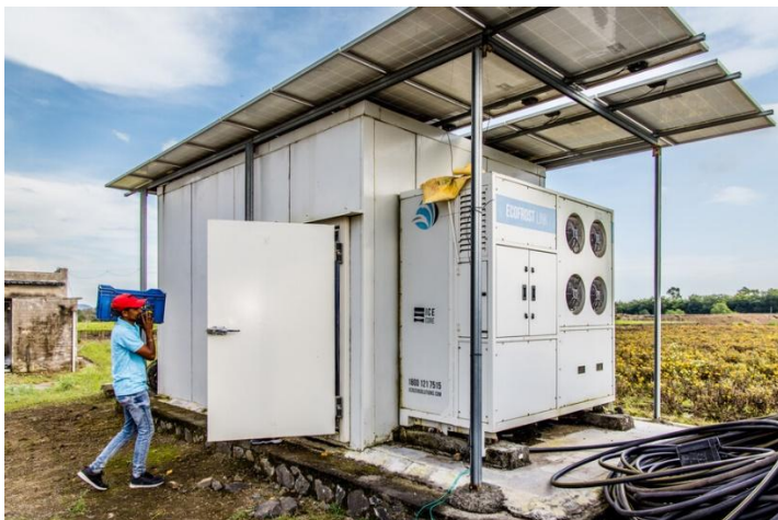
ECOZEN, ein Oikocredit-Partner aus Indien, bietet Bäuerinnen und Bauern ein mobiles, solarbetriebenes Mini-Lagerhaus für Obst und Gemüse. So verrottet bis zu 40% weniger Ernte. Foto: Opmeer Reports.
